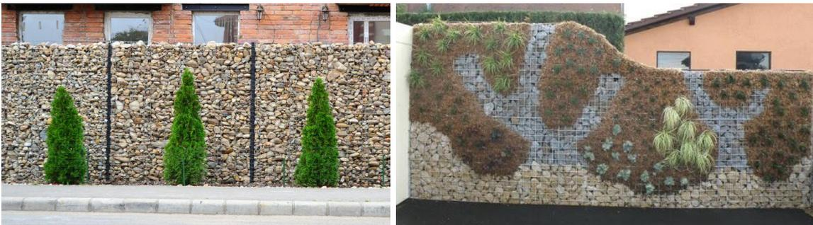
Figure 34 : Exemple de mur en gabion simple et végétalisé (Source : travauxavenue.com et ideesmaison.com)
