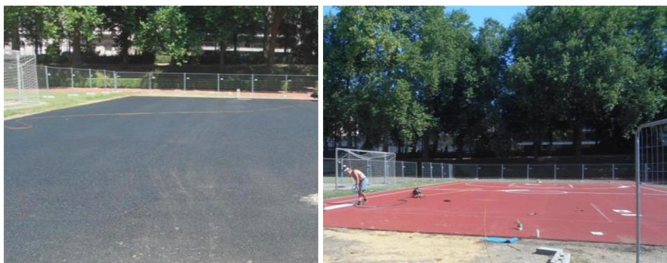
Figure 30 : Exemple de revêtement en caoutchouc coulé (type EPDM) mis en place dans le parc du cinquantenaire
