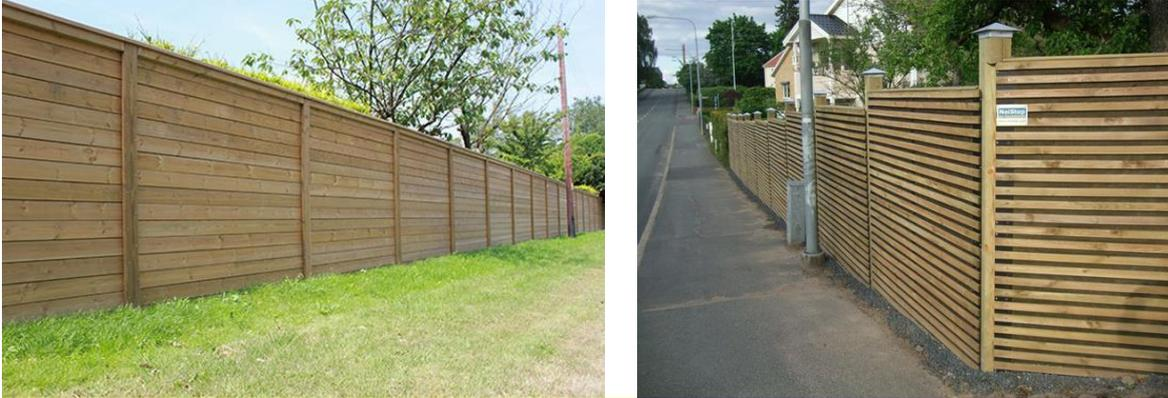
Figure 33 : Exemple de mur en bois avec et sans absorbant (Source : placedupro.com et technicontact.com)
